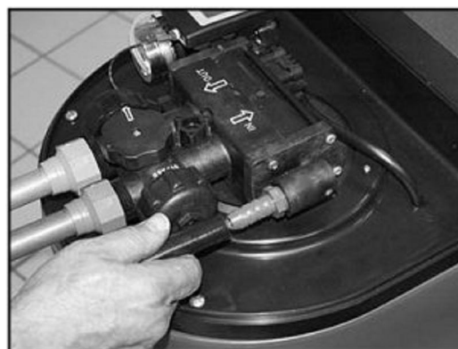
Рис. 3. Подсоединение дренажной линии
